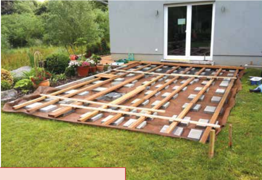
Eine hochwertige Unterkonstruktion ist der Grundstein für jede Terrasse. Foto: Thomas/stock.adobe.com
