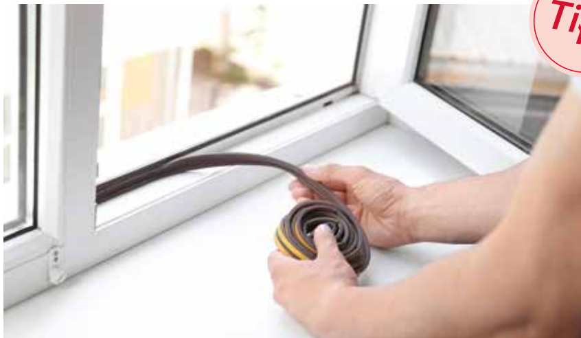
Die Wahl der richtigen Dichtungsmasse hängt von der Art des Fensters und der Größe der Fuge ab. Foto: New Africa/stock.adobe.com
